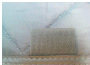
Fixation sur la base du toit (tôle) par ruban agrippant
